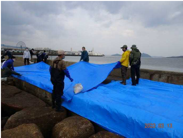
ワカメ揚陸のためのブルーシート展張
