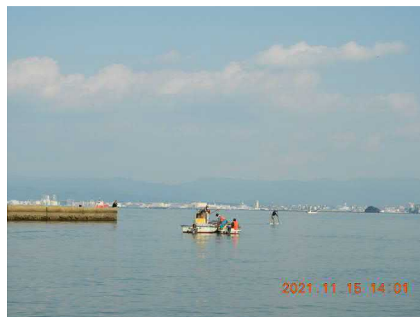
伝馬船にて幹ロープの突堤内への設置状況
